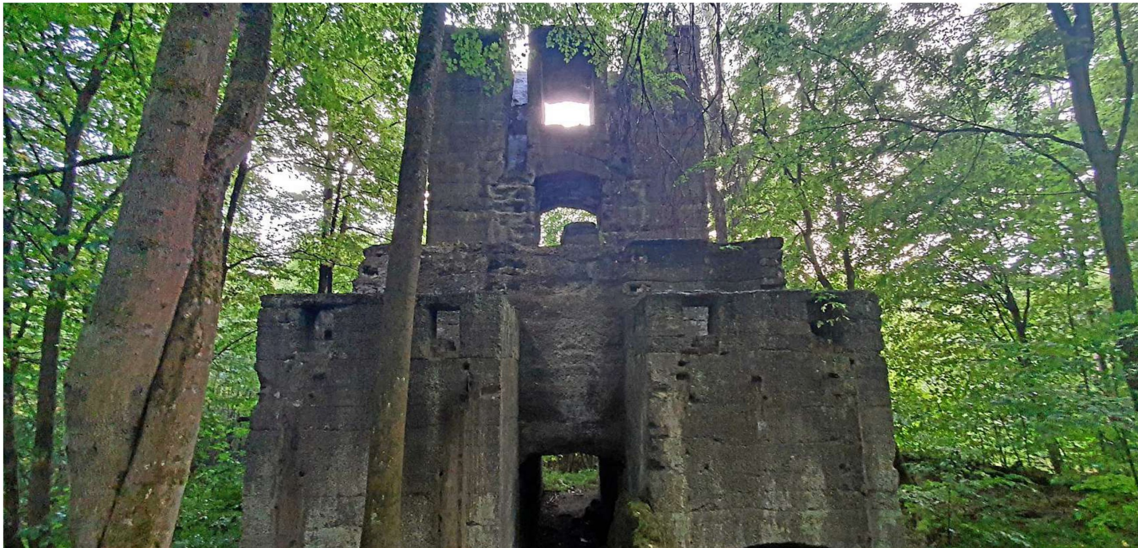
Im Wald hinter Walkenried, zwischen Bahnstrecke und Affenteich, liegt das alte Schotterwerk, dass 1913 geschlossen wurde.
