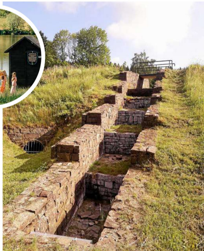
Solche „Ausfluten“ wie hier am Wasserläufer Teich verhinderten, dass das Wasser bei starkem Regen über den Damm abfließt. Stattdessen wurde es in tiefer gelegene Teiche geleitet.
